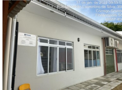
Obras do NEIM Fermínio receberam visita da SMTAC
